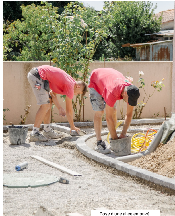
Pose d'une allée en pavé
