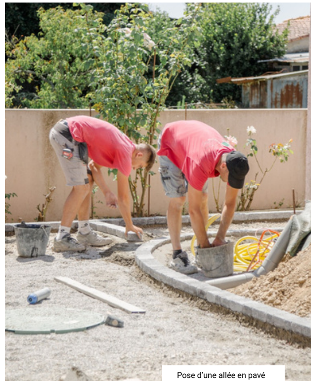
Pose d'une allée en pavé
