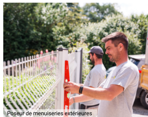
Poseur de menuiseries extérieures
