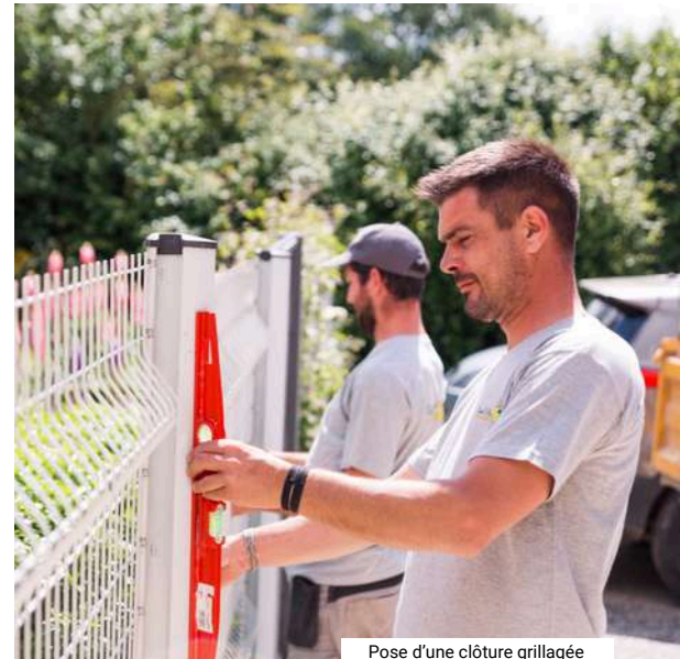
Pose d'une clôture grillagée
