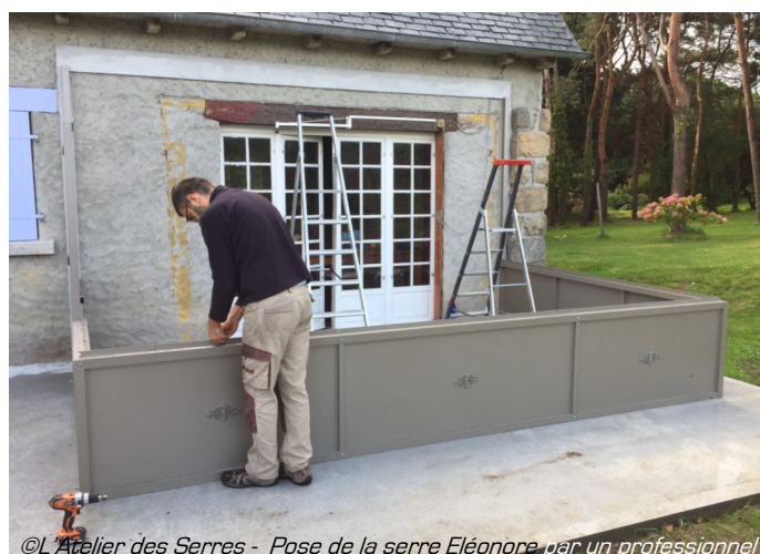
©L'Atelier des Serres - Pose de la serre Eléonore par un professionnel
