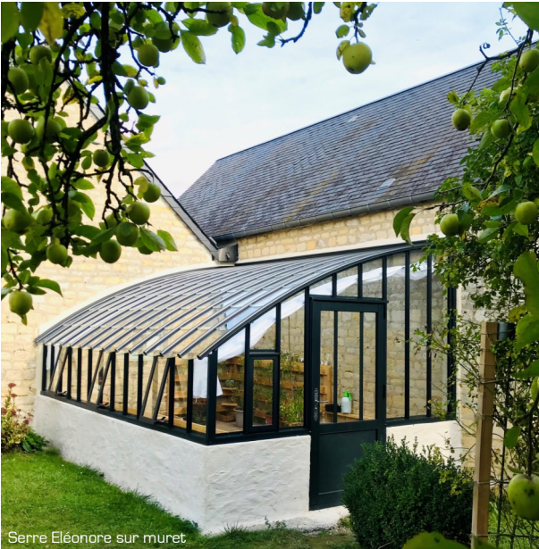
Serre Eléonore sur muret
