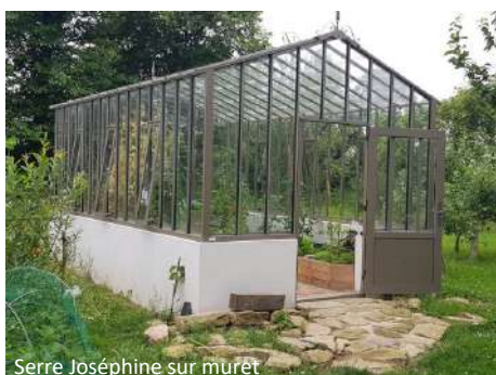
Serre Joséphine sur muret
