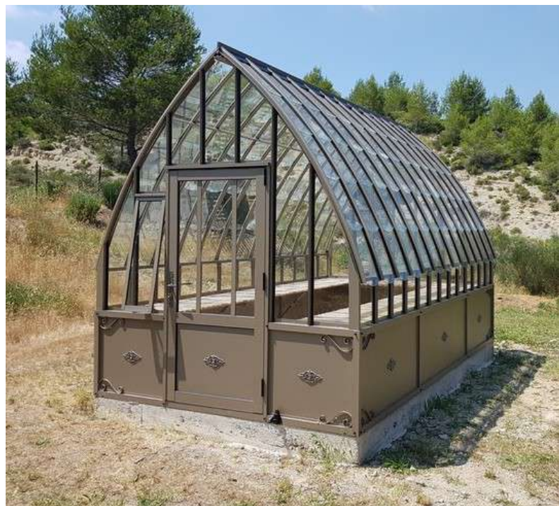
©L'Atelier des Serres - Serre Eugénie soubassement
