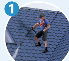
1 APPLICATION DU NETTOYANT TOITURES SUR LE TOIT
